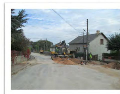
A la cité Beausoleil, les travaux de réfection des réseaux avec enfouissement des lignes électriques et téléphoniques sont effectués et ont été suivis par l'aménagement de la chaussée et des trottoirs.
