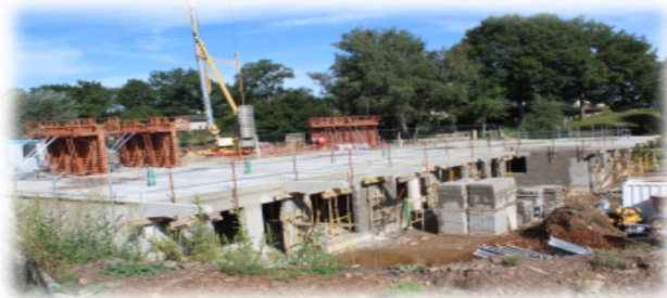
Avancée des travaux le 18 août 2019
